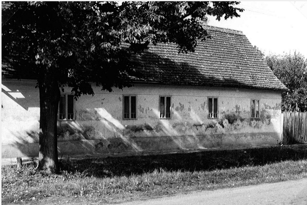
Slika 2 Prva kuća zadruge Domčević u Privlaci, obnovljena i danas u ulici Faličevci 67 (kuća br. 1) (Zbirka DOMAC)
