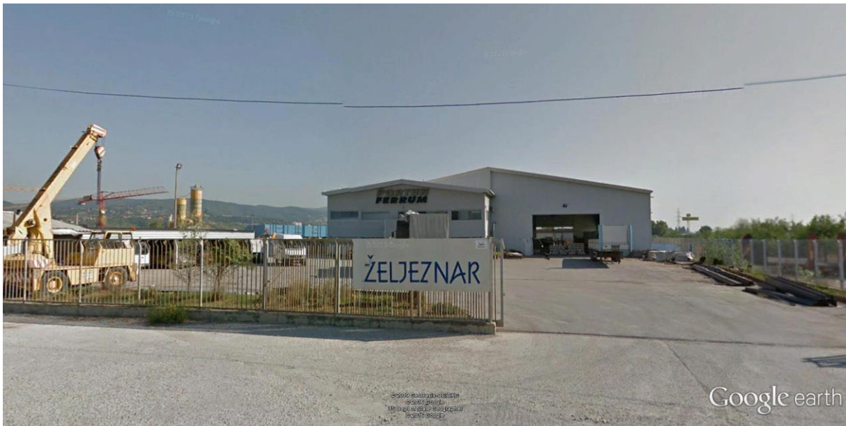
Slika 6: Fotografija lokacije tvrtke Portun Ferrum d.o.o..
