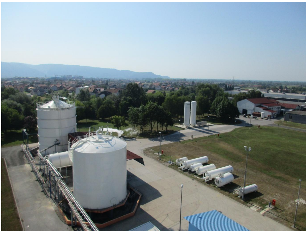
Slika 4: Skladišni rezervoari za tekući kisik i tekući dušik. (vlastita fotografija)
