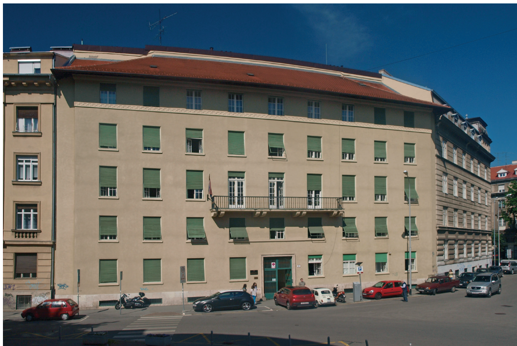
Zgrada u Domagojevoj ul. 2
