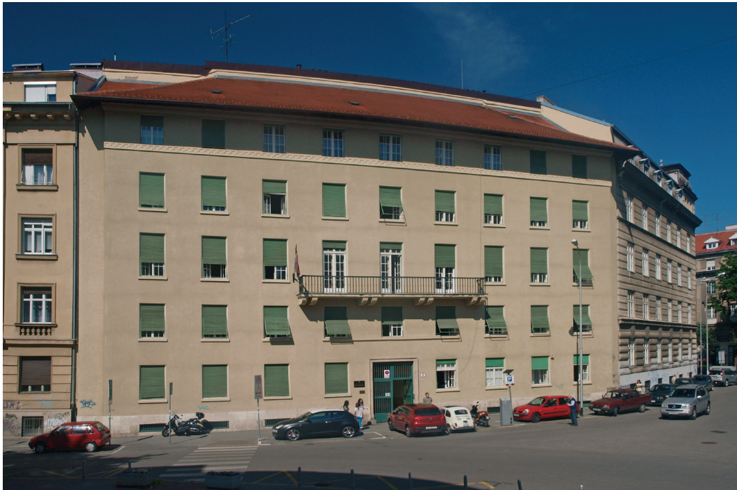
Zgrada u Domagojevoj ul. 2
