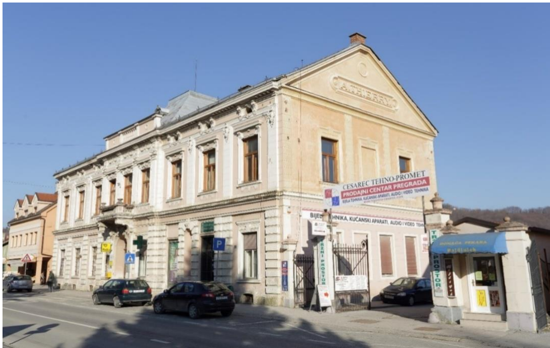
Slika 4. Zgrada u Pregradi u kojoj se nalazila ljekarna obitelji Thierry (preuzeto iz Inić i Flegar, 2017.)
